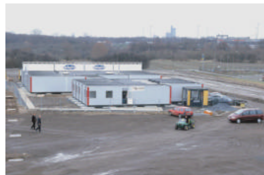
Gebäude von BIG BROTHER in Hürth-Efferen
